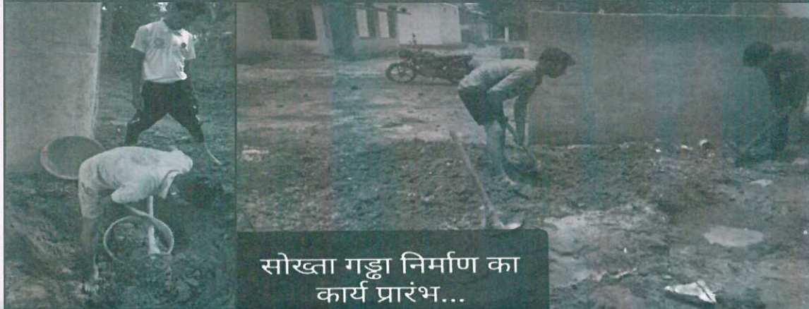
सोख्ता गड्ढा निर्माण करते स्वयंसेवक...
